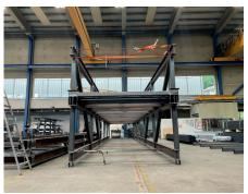
Weiter gibt es eine 17 Meter lange einstöckige Passerelle zum Werk 2. Ohne Fassade wiegt diese zehn Tonnen. Im Gegensatz zur Passerelle ins Werk 3, wird der Boden, die Fassade und das Dach bei dieser Passerelle bereits vormontiert. Dies hat den Vorteil, dass die fertige Passerelle in einem Nachteinsatz montiert werden kann und die darunterliegende Röhrlistrasse nicht gesperrt werden muss. Die Montage dieser Passerelle wird zwischen Oktober und Dezember erfolgen.
